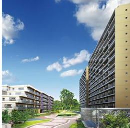
上:クラブハウス、下:住居棟
